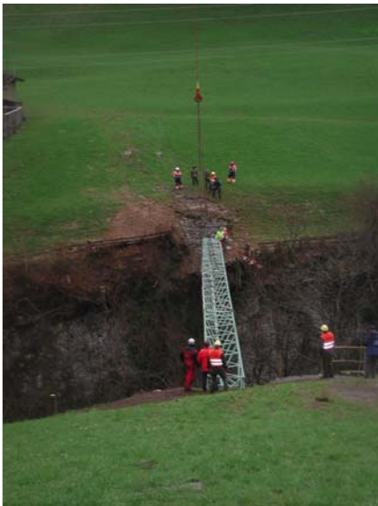
Foto 5: Millimeterarbeit bei der Montage
