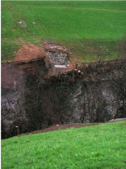
Foto 3: Widerlager Seite Emmetten
